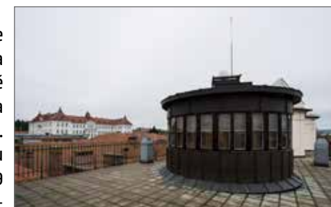
Obr. 2.1: Kladivova observatoř na střeše budovy "A" Fakulty stavební Vysokého učení technického v Brně
