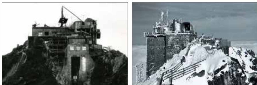
Obr. 5.4: Výstavba Observatória Lomnický štít
