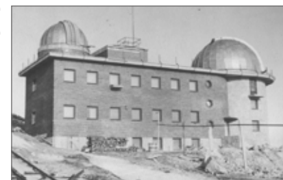
Obr. 5.3: Výstavba Observatória Skalnaté pleso
