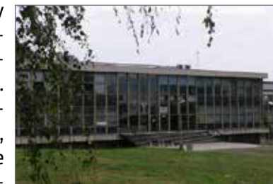
Obr. 3.1: Budova Vývojových dílen v areálu MFF UK v Troji, kde sídlí AÚ UK.
